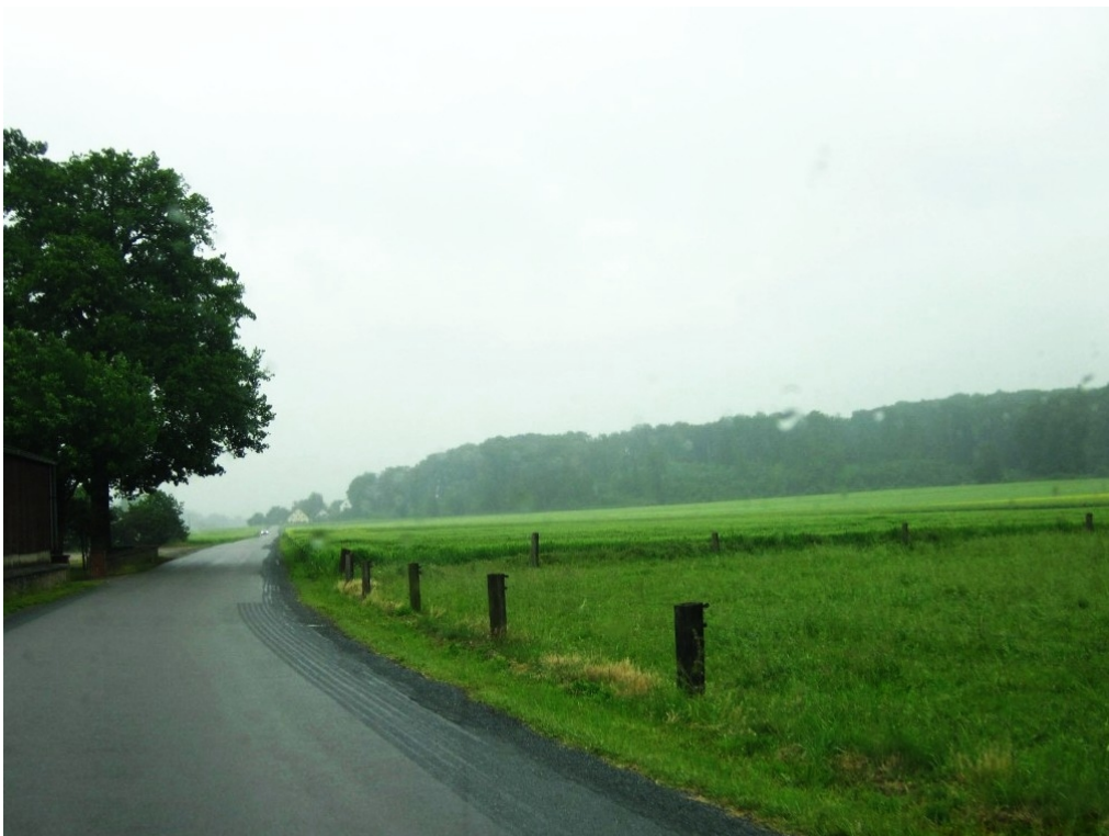
Bild 4: Blick entlang der "Natberger Straße" in östliche Richtung.
