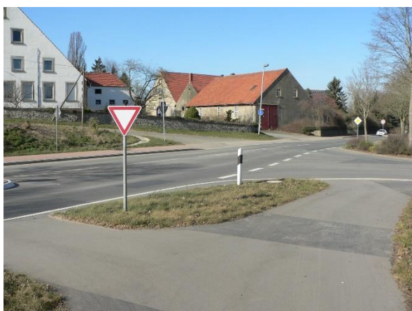
Einmündungsbereich „Natberger Straße“ / „Lüstringer Straße“ (K 321)
