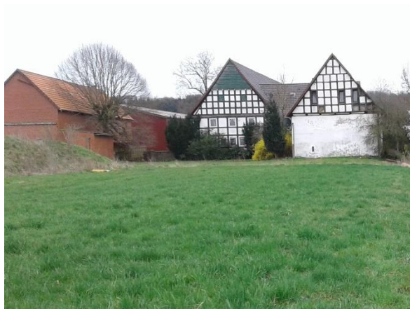
Denkmalgeschützte Anlagen auf Hofstelle
