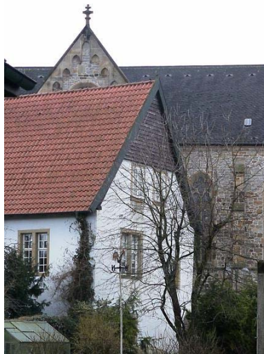
Blick auf Kirche und Haus Bissendorf im Ortskern Bissendorf
